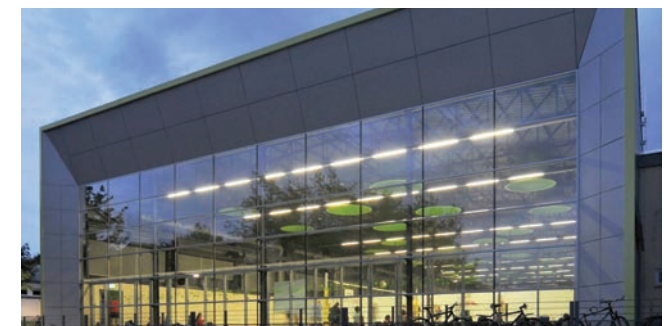
Sporthalle TU Dresden Nöthnitzer Straße, 01187 Dresden Architekten: meyer-bassin und partner, freie architektenbda, Dres- den, Bauherr/in: Freistaat Sachsen © meyer-bassin und partner
