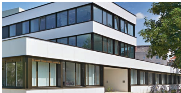
Leibniz-Institut für Ökologische Raumentwicklung Weberplatz 1, 01217 Dresden Architekten: F29 Architekten, Dipl.-Ing. BDA Christian Schmitz & Dipl.-Ing. BDA Peter Zirkel, Dresden Bauherr/in: Leibniz-Institut für Ökologische Raumordnung © F29 Architekten
