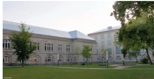
Sanierung Hochschule für Bildende Künste Güntzstraße 34, 01307 Dresden Architekten: codeunique, Dresden Bauherr/in: Freistaat Sachsen © codeunique
