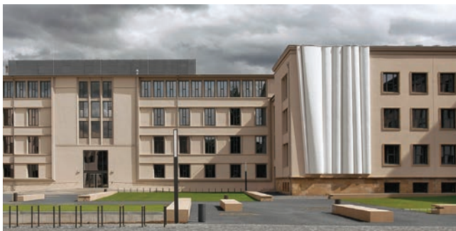
Staatliche Studienakademie und Evangelische Hochschule für Soziale Arbeit Dürerstraße 25, 01307 Dresden Architekten: ARGE kisterscheithauergrossarchitekten und stadtplaner GmbH, Leipzig mit Rohdecan Architekten GmbH, Dresden Bauherr/in: Freistaat Sachsen © ARGE kisterscheithauergrossarchitekten und stadtplaner GmbH mit Rohdecan Architekten GmbH, Foto: Andreas Kempe
